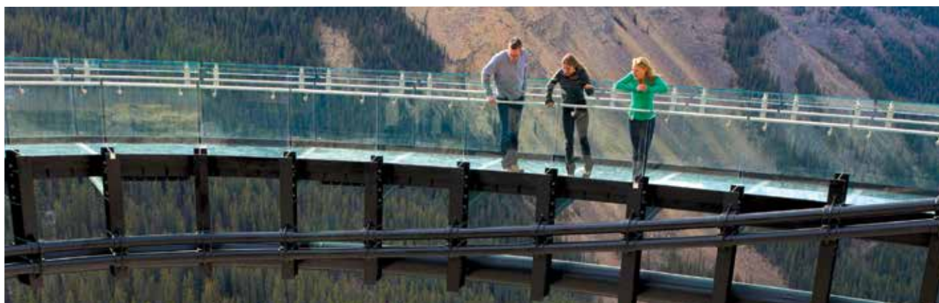
Zapierający dech w piersiach pomost Glacier Skywalk, wystający z czola klifu, to znakomity przykład zastosowania przekładek jonoplastycznych SentryGlas®.
