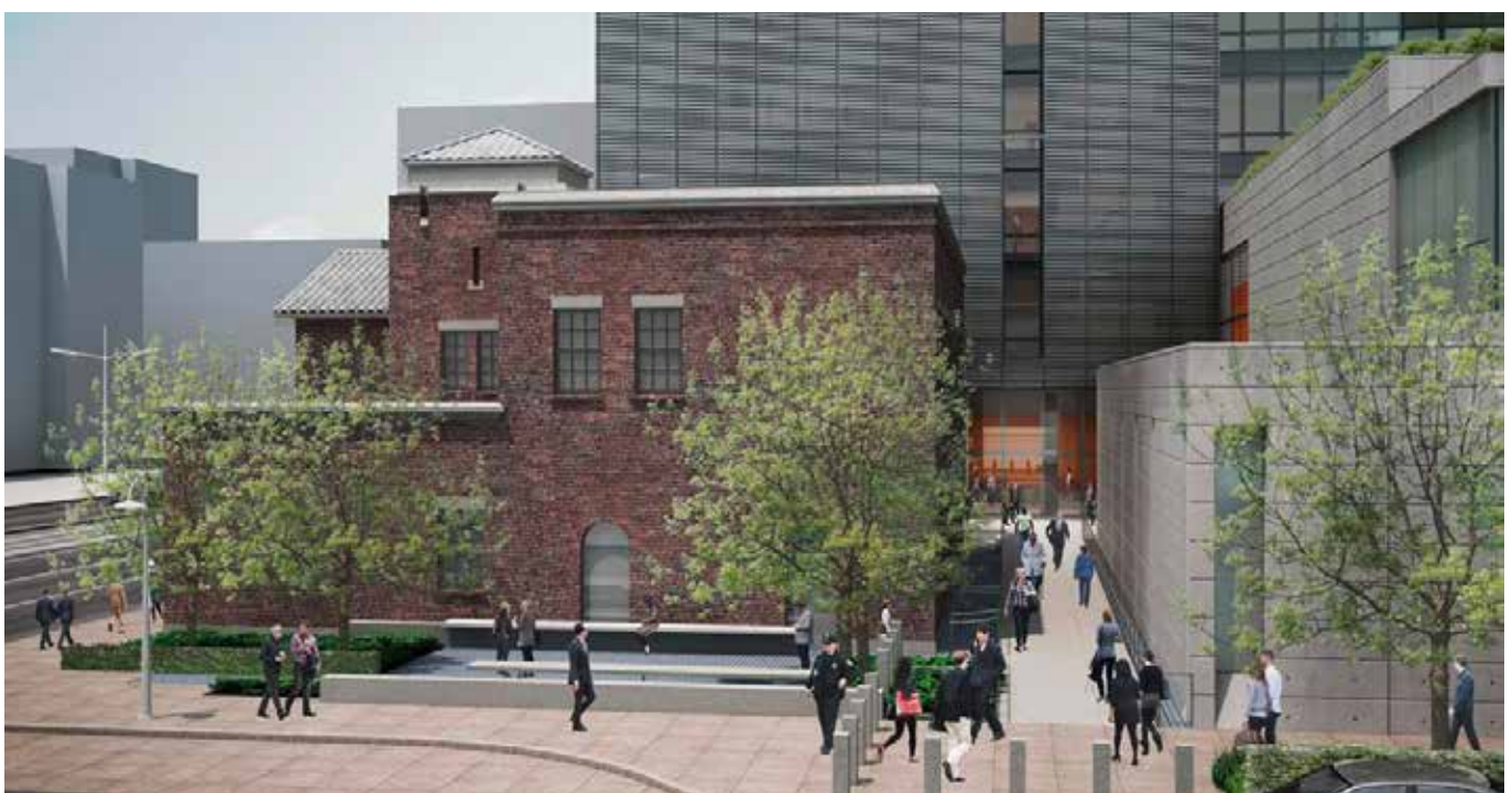
Kuloodporne szkło laminowane z przekładkami SentryGlas® zamontowano na większej części zewnętrznych elewacji.
