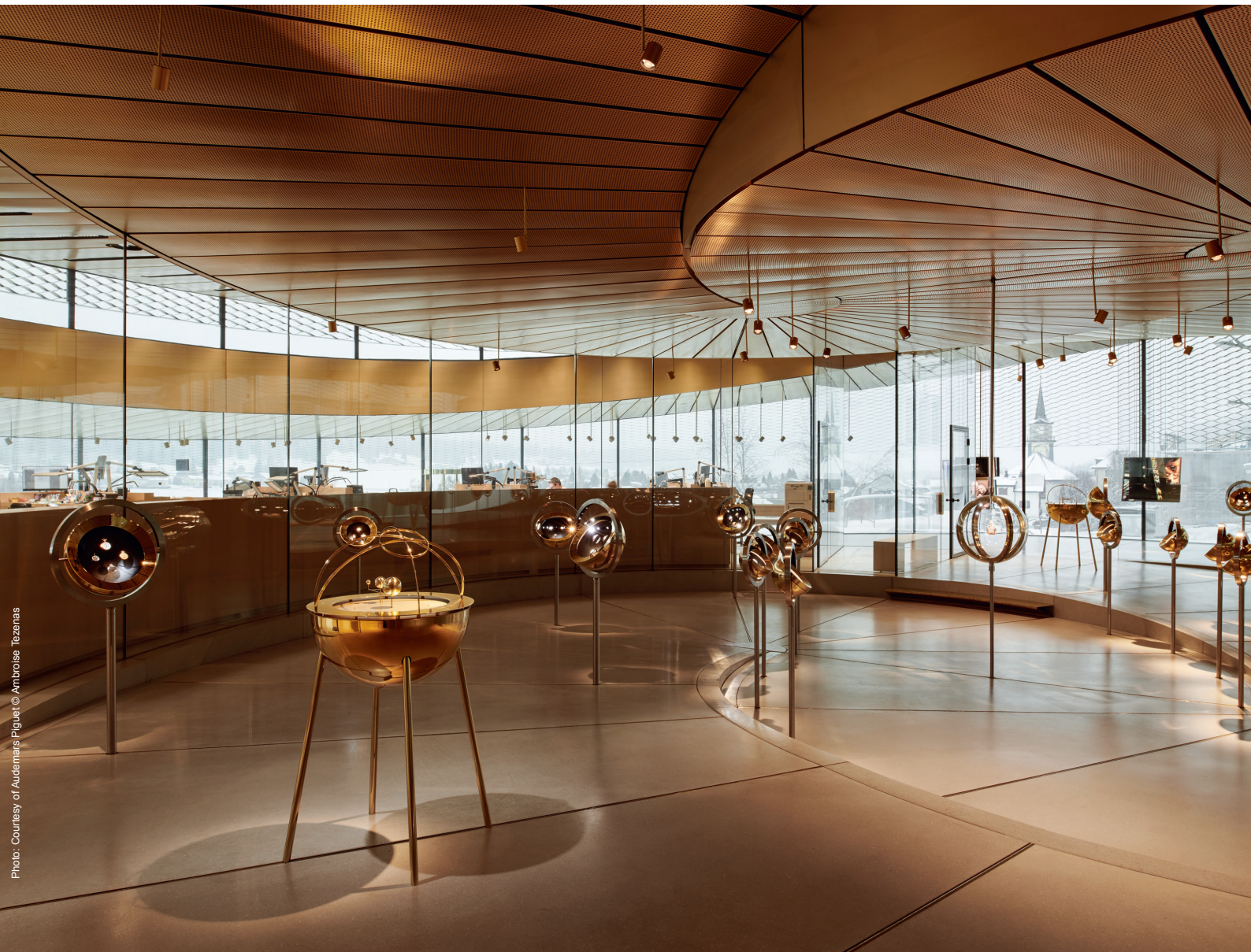
곡선형 내력 유리 패널은 3중 접합유리 글레이징으로 되어 있으며, 구조용 실리콘으로 부착하여 강철 캡에 기하학적으로 고정했다.
