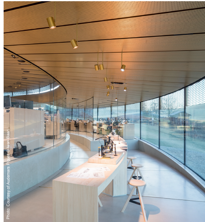
곡선형 내력 유리 패널은 3중 접합유리 글레이징으로 되어 있으며, 구조용 실리콘으로 부착하여 강철 캡에 기하학적으로 고정했다.
