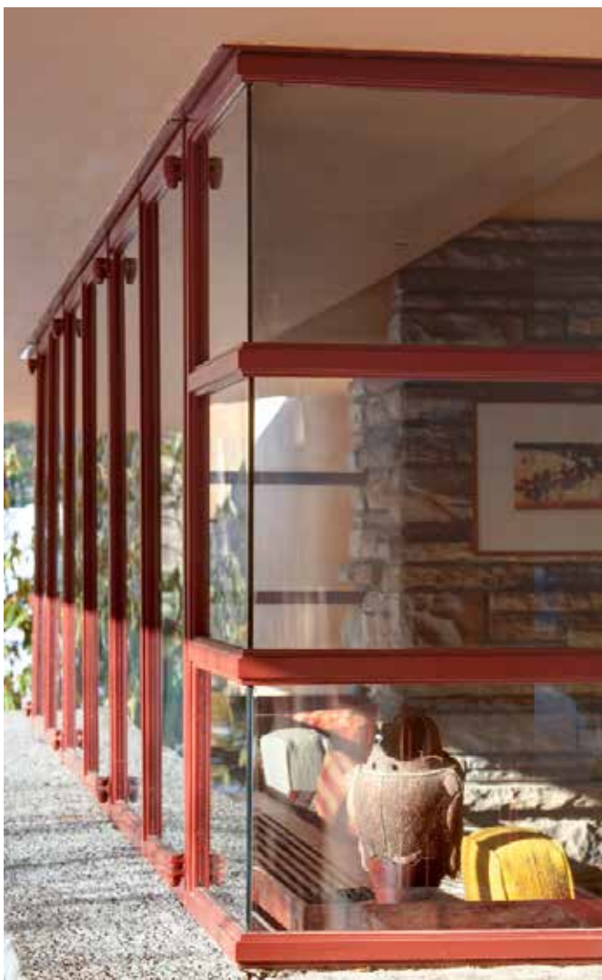
Die herausragende Kantenstabilität von SentryGlas® ermöglichte den Einsatz einer Stoßfugen-Konstruktion.
